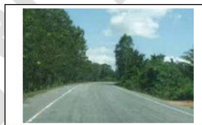
กม. ๕.๕๕๕ ± ๐.๐๐๐ (สภาพสายทางโดยทั่วไป)
