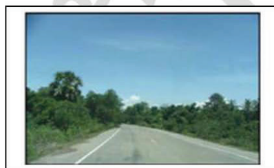
กม. ๗.๗๗๗ ± ๐.๐๐๐ (สภาพสายทางโดยทั่วไป)
